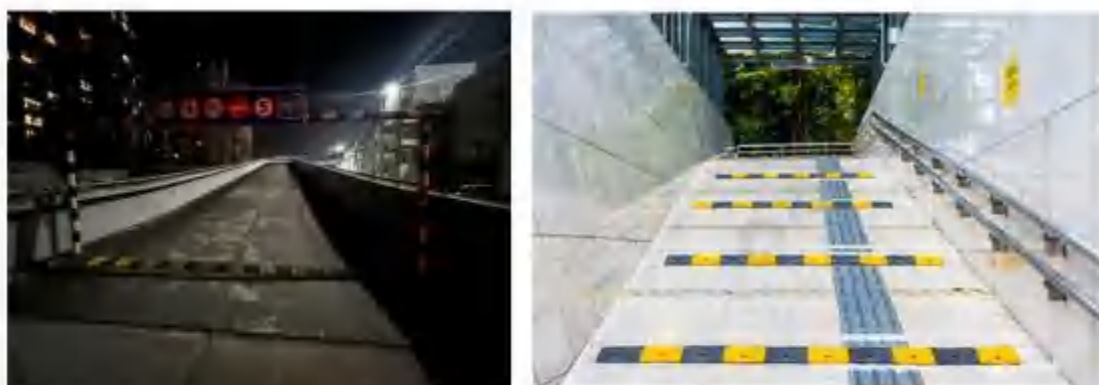
图 1-2 上海某地桥梁下行及地下车库下坡路段减速带
